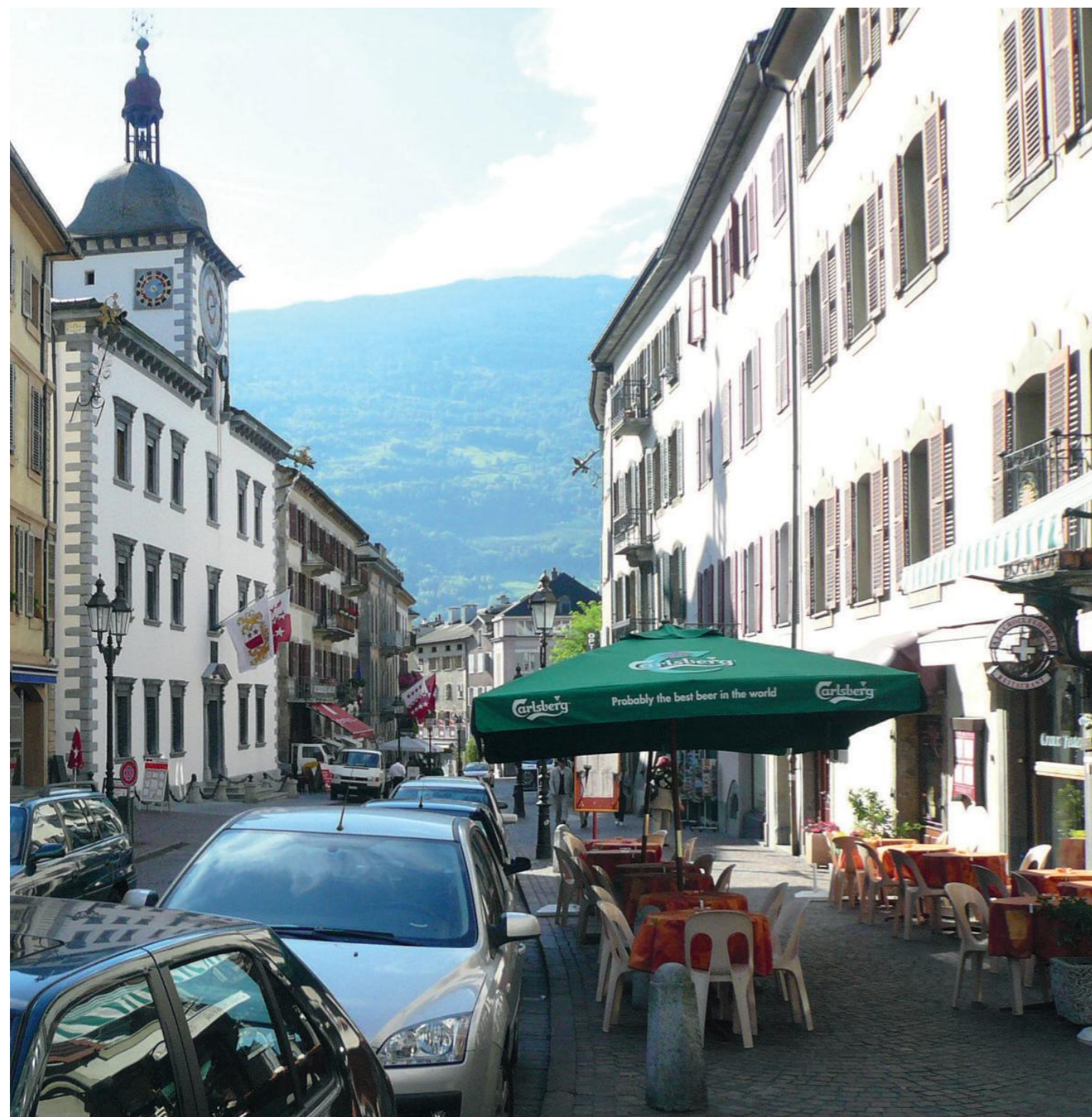
Le Grand Pont à Sion avant sa transformation
