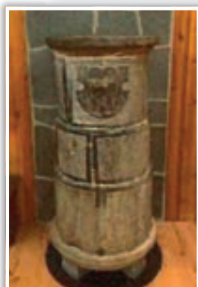
Pierres ollaires mis en conformité suivant les exigences du rapport du ramoneur en 2021
