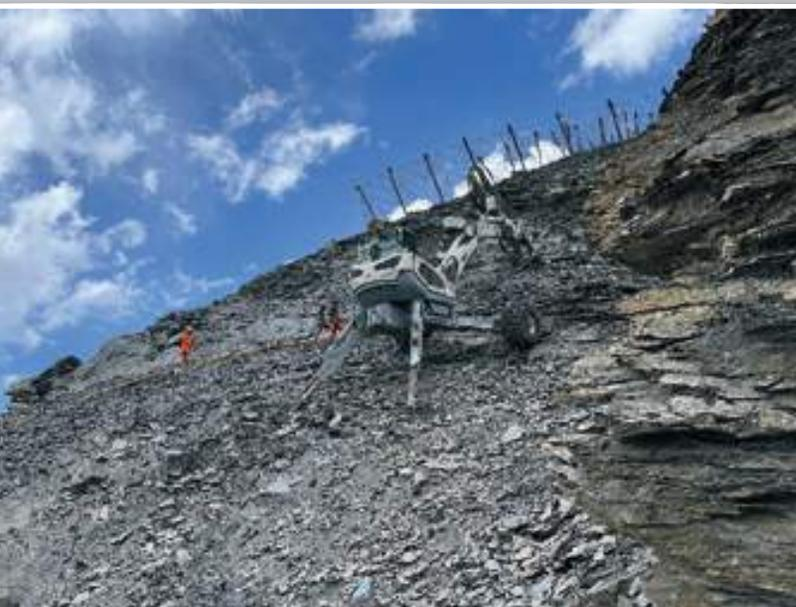
Les travaux 2023 ont consisté en la réalisation de tous les ancrages forés pour la pose de la dernière étape de filets paravalanches prévue. Cela représente plus de 3'300 m<sup>3</sup> de forages et 90 tonnes de mortier d'injection spécialement conçu pour les régions avec risque de permafrost (sol gelé en profondeur). Ces travaux ont été réalisés de manière efficace et dans les délais prévus au moyen de deux pelles araignées spécifiquement équipées à cette fin (glissières de forage).
