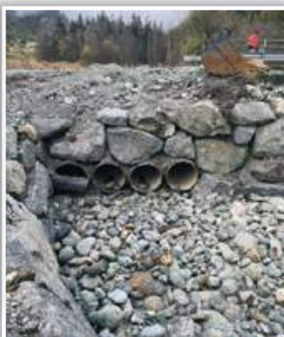
Aménagement du passage inférieur en rive droite (tuyaux PRV)
